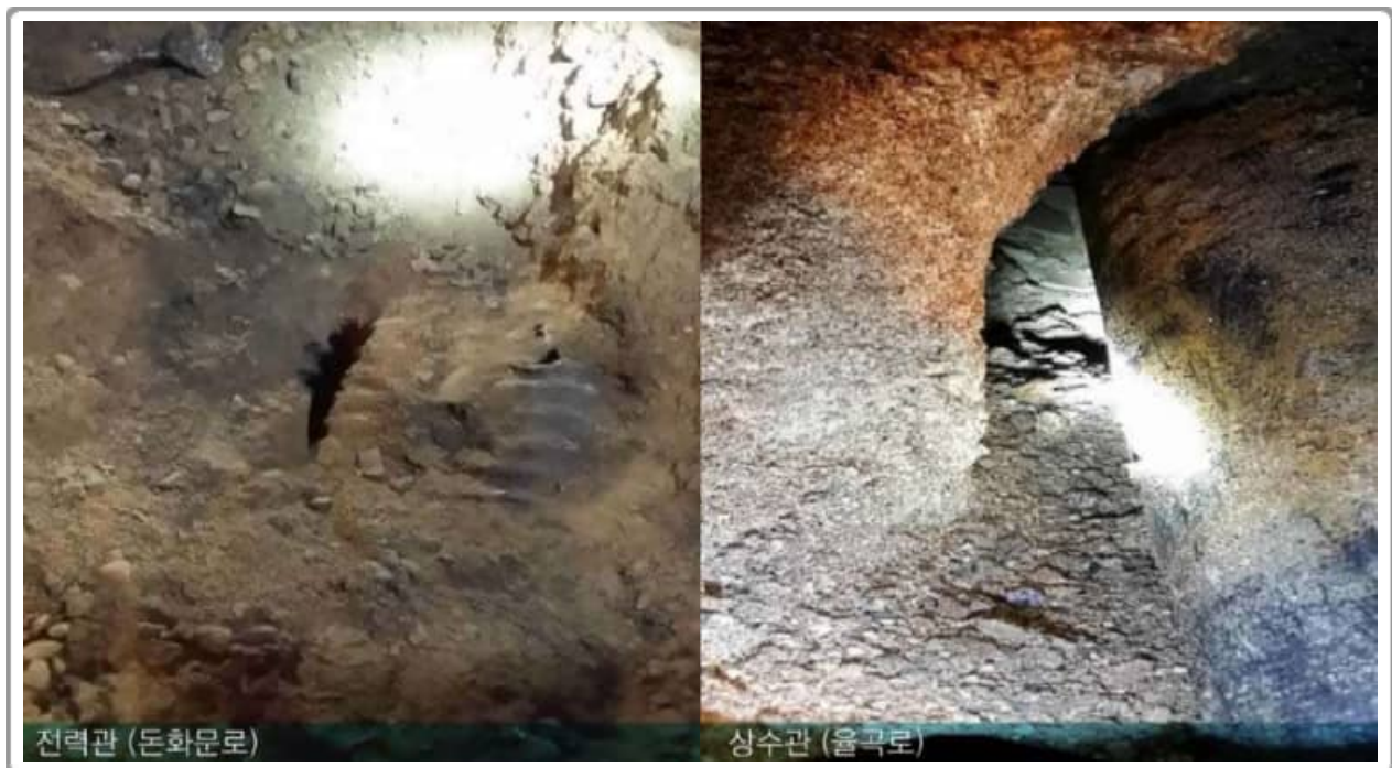
그림 3-8. 돈화문로 다짐불량에 의한 공동발생 사례
