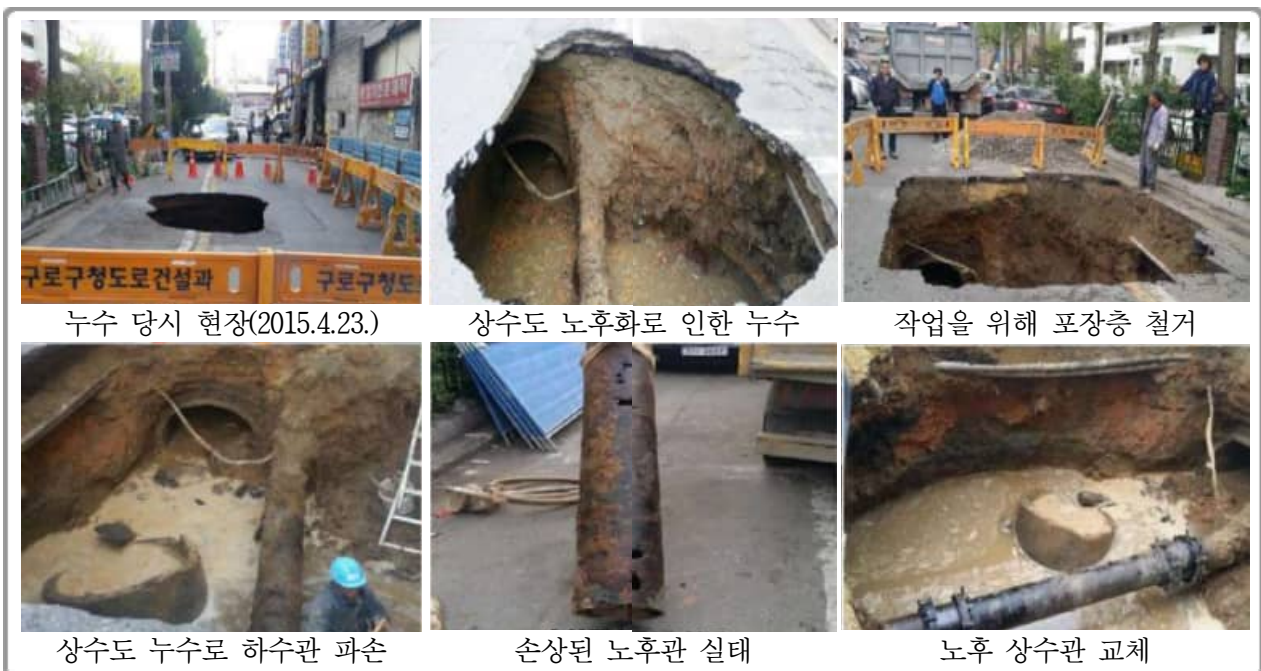
그림 3-6. 구로 중앙로 상수관 노후화에 의한 지반침하 발생 사례
