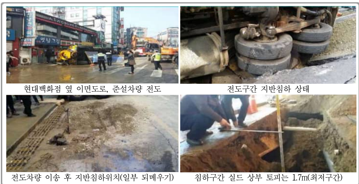
그림 3-12. 신촌 하수관 시공 중 지반침하 발생 사례
